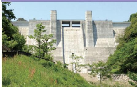
石井ダムは洪水調節とレクリエーションを目的に作られました。堤高66.2m、堤頂長155mのダムで、堤体の中には多目的のホールがあり、ダムの屋上部は展望台として開放しています。
