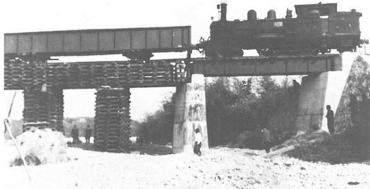
万勝寺川橋梁
