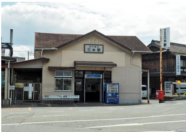
焼失した本駅舎（西側）
