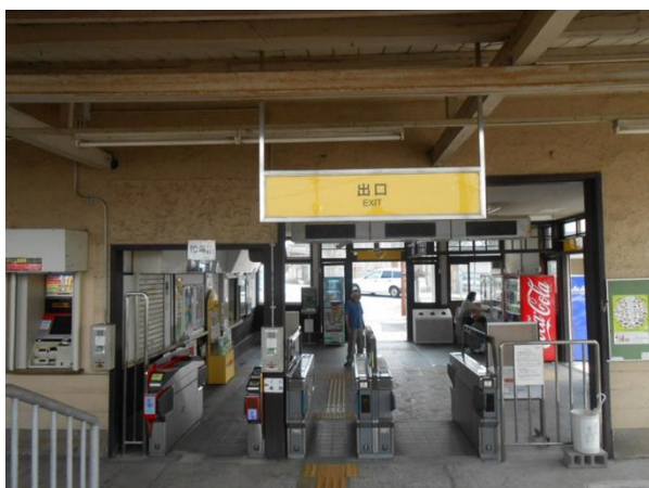
焼失した本駅舎の内部
