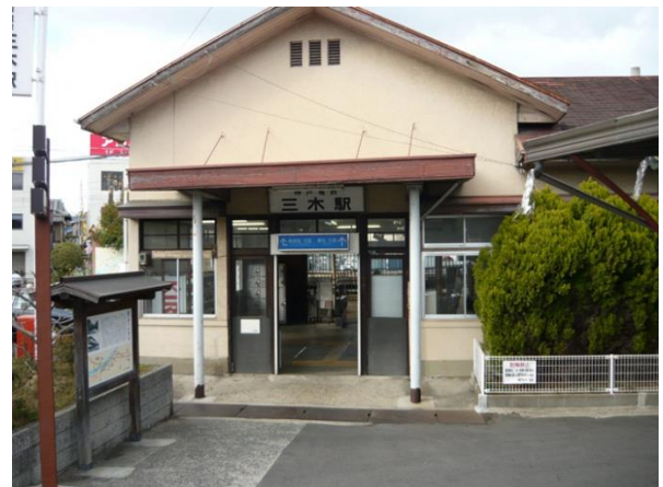
焼失した本駅舎（南側）
